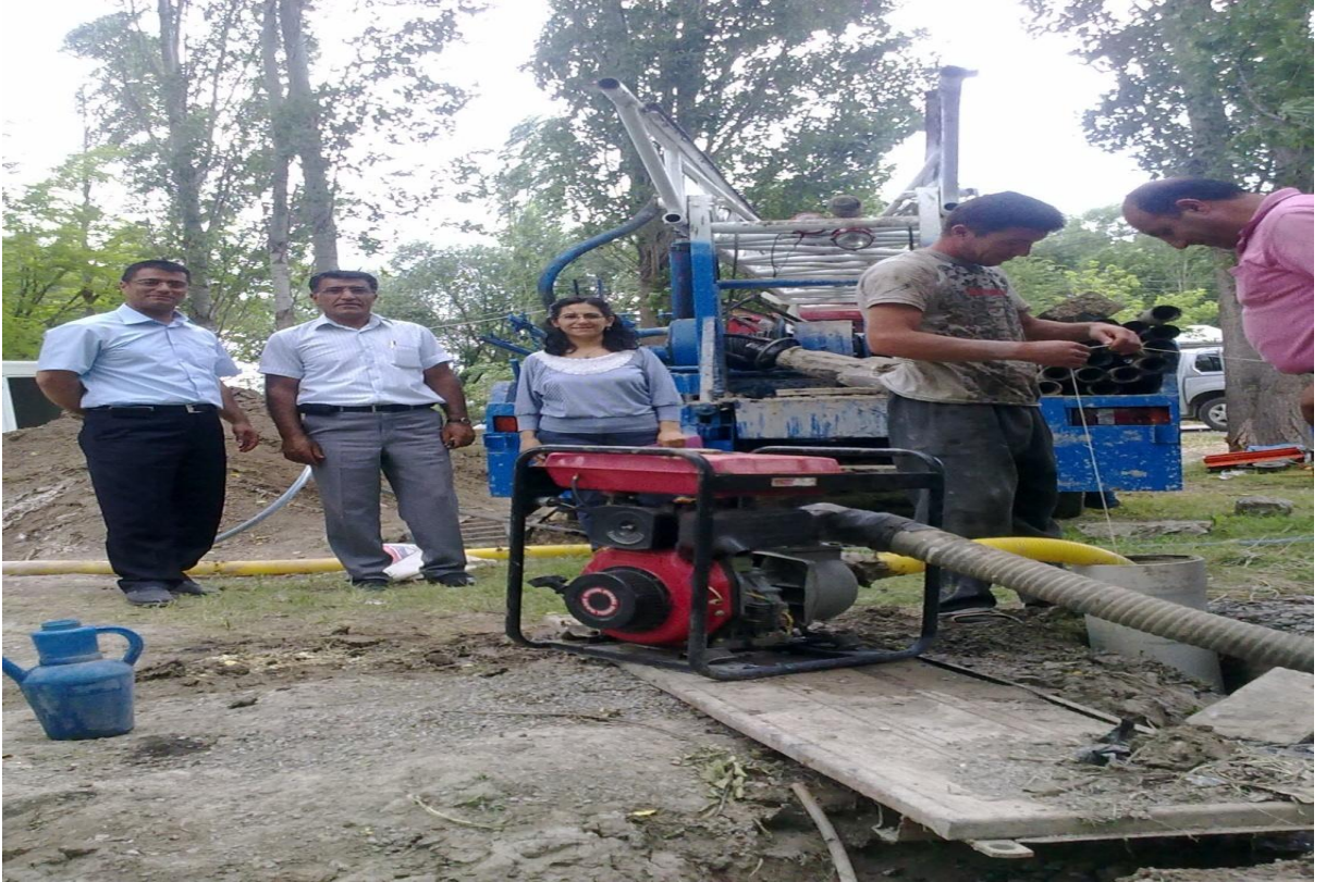
Necefali ve Kadıkışlak köyleri içme suyu amaçlı sondaj kuyusu açılması işi
