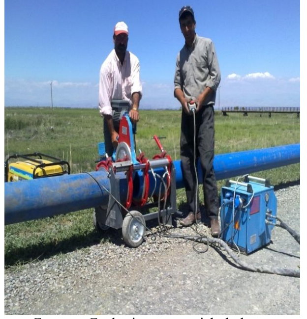
Gürgüre Grubu içme suyu ishale hattı Yenileme işi ( alım kaynağı yapılması)
