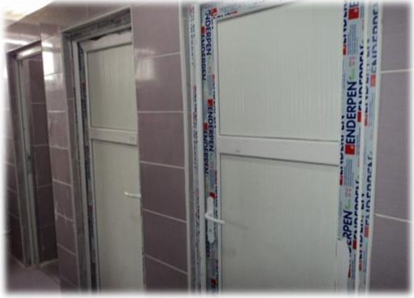
Iğdır Ticaret Lisesi Bakım Onarım İşi.
