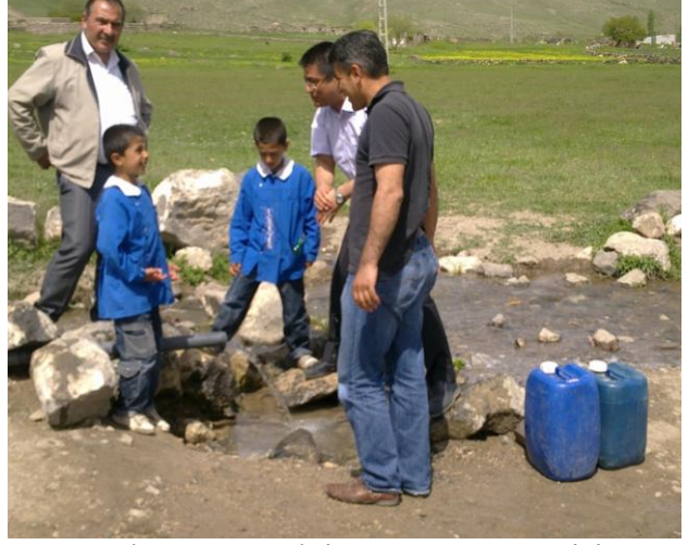
Taşlıca Köyü ek içme suyu yapım işi
