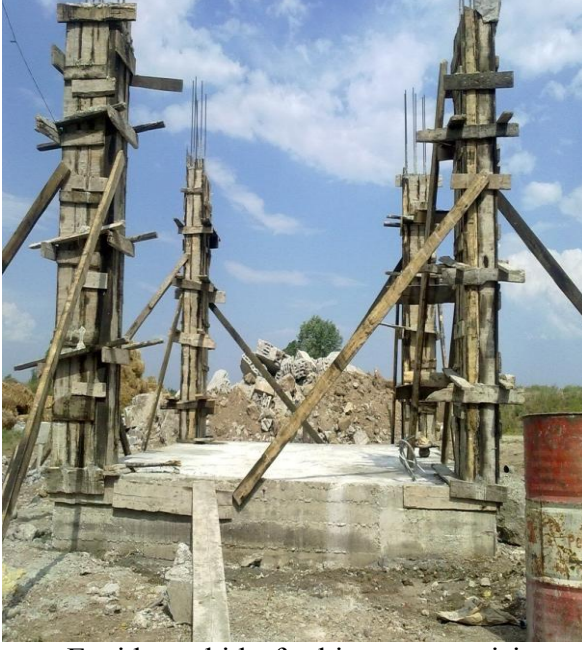
Evcı köyü hidrofor binası yapım işi
