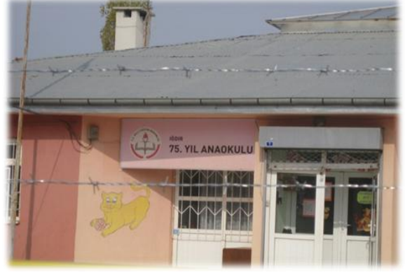
Merkez 75. Yıl Anaokulu Bakım Onarım İşi
