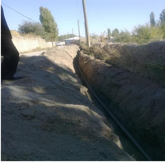
Mürşitali Köyü içme suyu şebeke hattı yenileme işi
