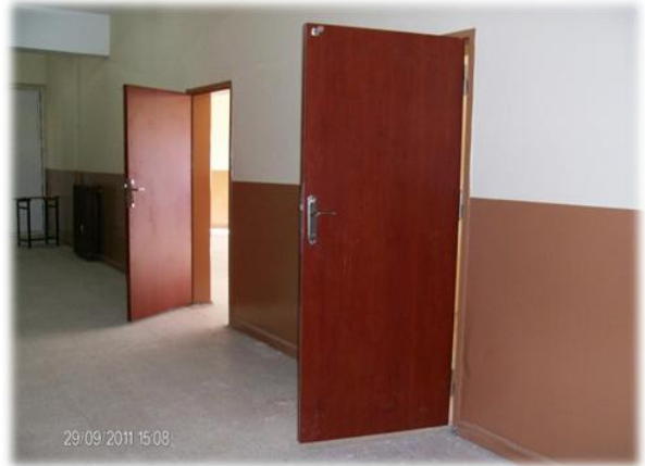
Aralık Teknik Lise ve Kız Meslek Lisesi Bakım Onarım İşi.
