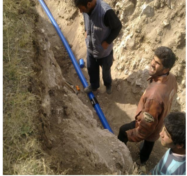
Taşuçan Köyü ve Koçbaşı Mezrası içme suyu ishale hattı yenileme işi
