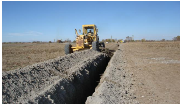
Döşenmiş Drenaj Hattının Kapatılması
