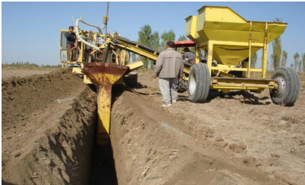
Drenaj Borusunun Döşenmesi
