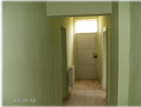
Atatürk Lisesi Bahriye Hadiüçer Kız Pansiyon Binası Bakım Onarım İşi.
