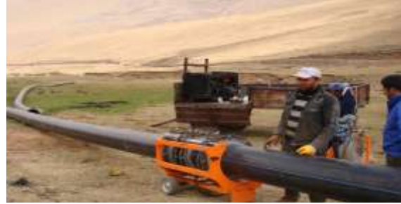
HDPE Boru Kaynak İşlemi
