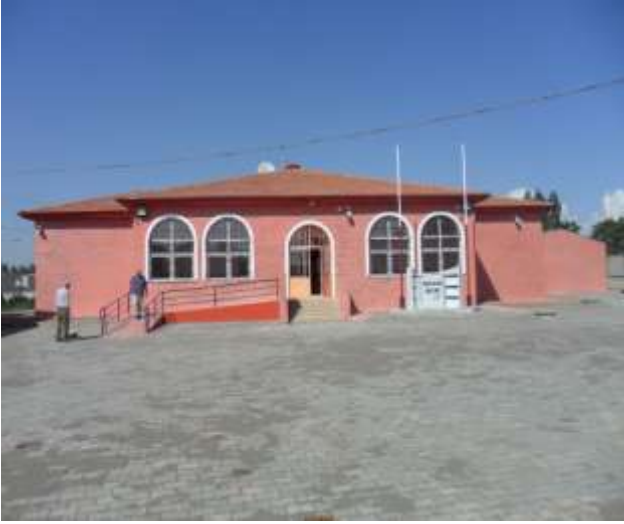
Hacıağa Köyü 4 Derslik Okul Yapımı
