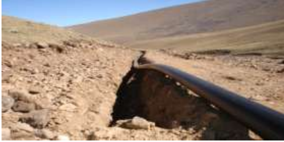
Su İletim Borusu Montajı
