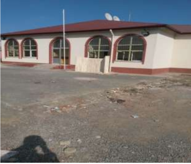
Babacan Köyü 4 Derslik Okul Yapımı
