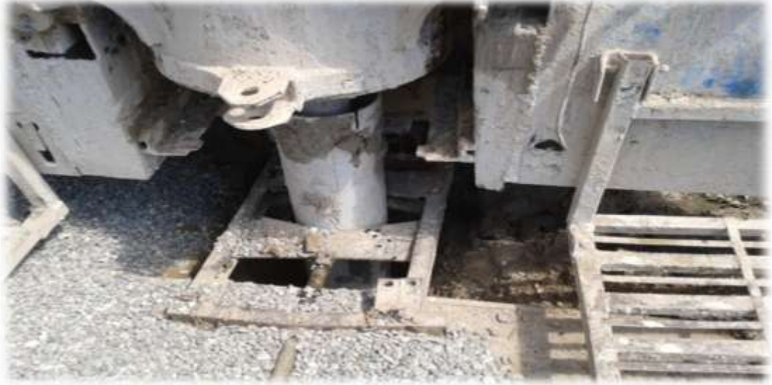
Orta Alican Köyü Yeni Sondaj Kuyusu Açılması ve Terfi Binası Yapım İşi
