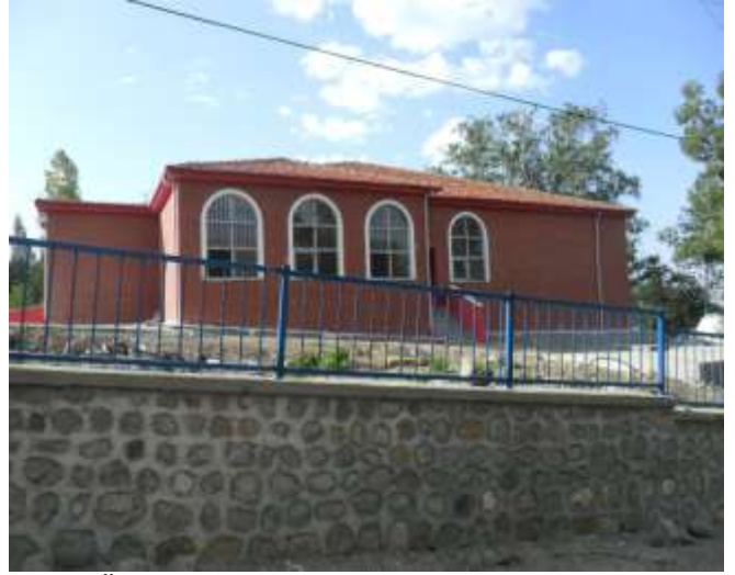
Üçkaya Köyü 4 Derslik Okul Yapımı
