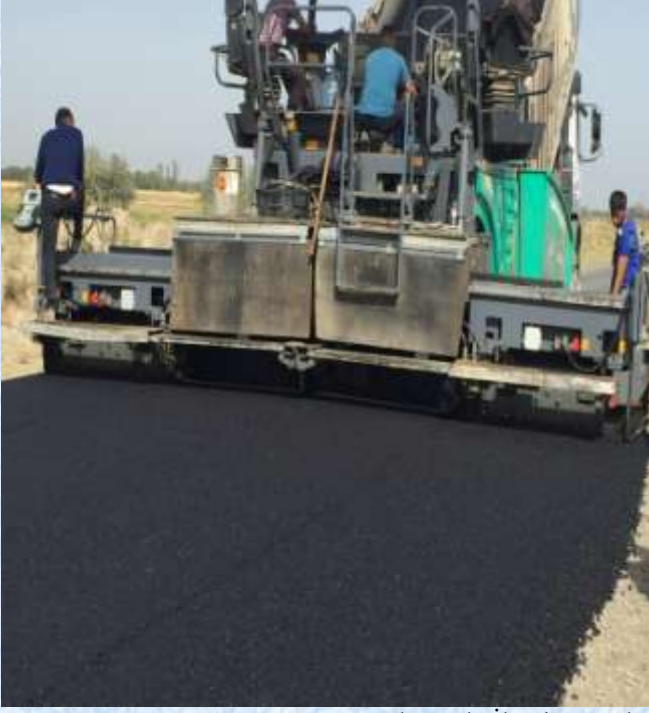
Karakoyunlu İlçesine Bağlı Köy Yollarına Sıcak Asfalt Yapımı
