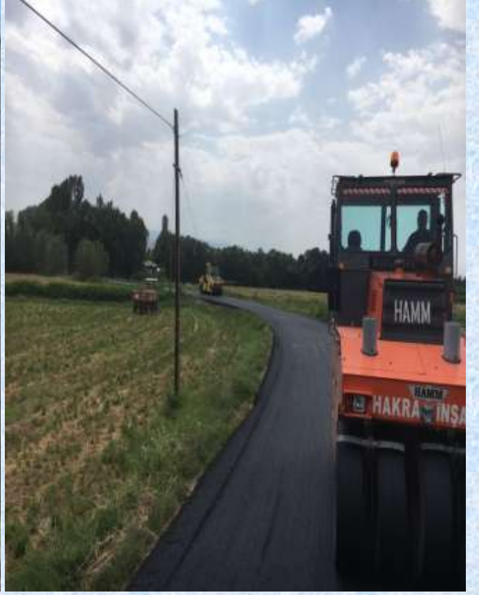
Köy Yollarına BSK Asfalt kaplama işi
