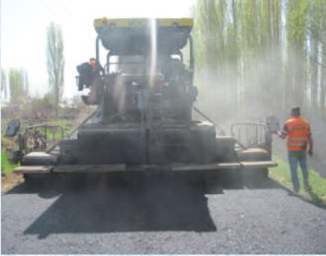
Merkeze Bağlı Köy Yollarına Sıcak Asfalt Yapımı
