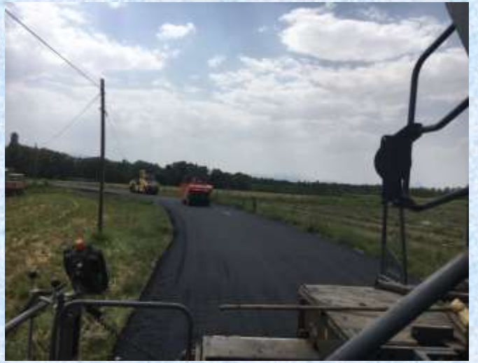
Merkeze Bağlı Köy Yollarına Sıcak Asfalt Yapımı
