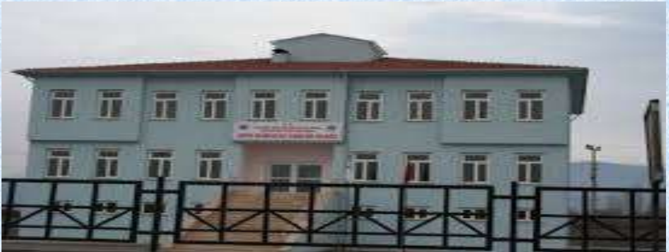
Sağlık ocağı bakım onarım işi
