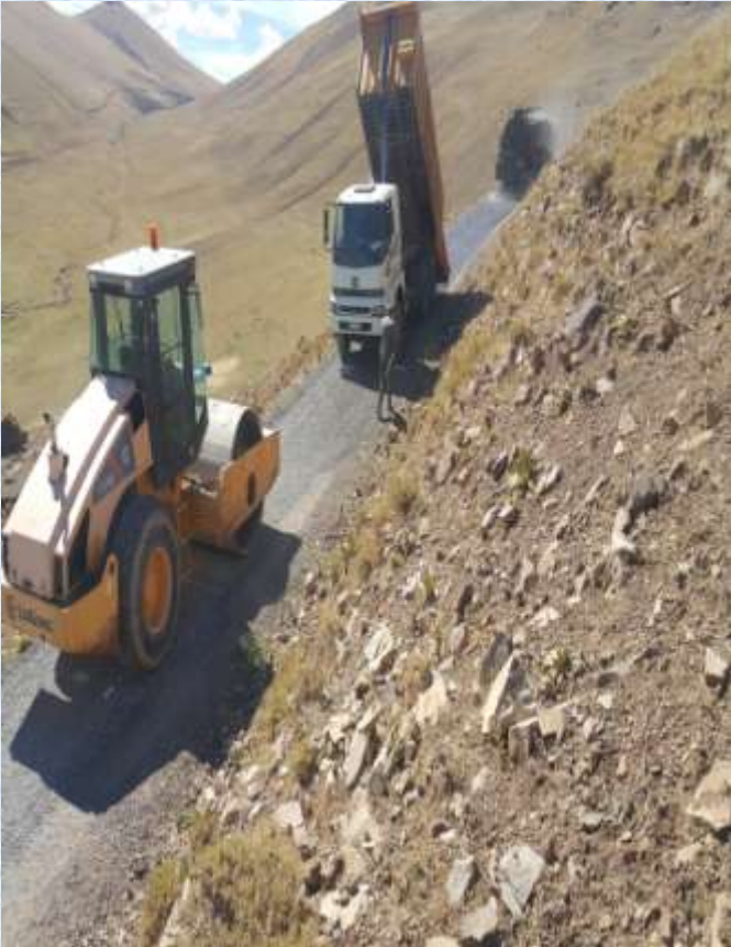
Tuzluca İlçesine Bağlı Köy Yollarına 1.Kat Asfalt Yapımı
