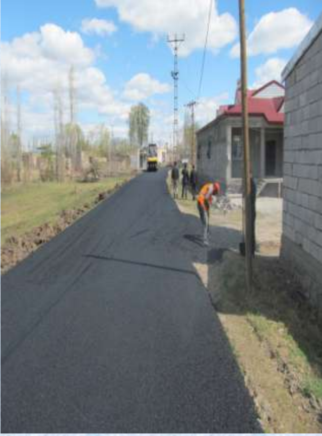
Köy Yollarına BSK Asfalt kaplama işi
