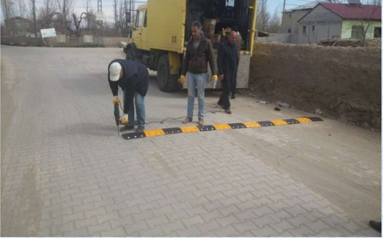
Mutelif Köy Yollarına Hız Kesici Kasis Yapımı
