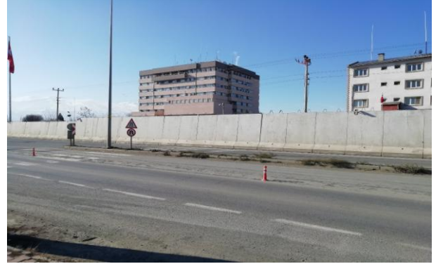
Emniyet Müdürlüğü Hizmet Binası ve Lojmanlarına Beton Duvar ve Bariyer İş
