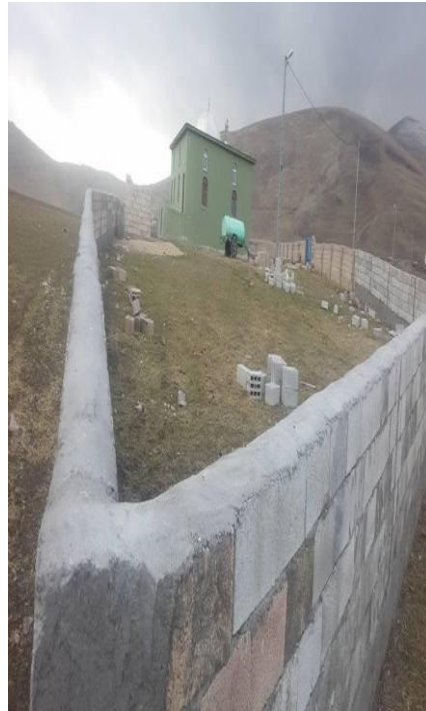
Cami İhata Duvarı Yapımı
