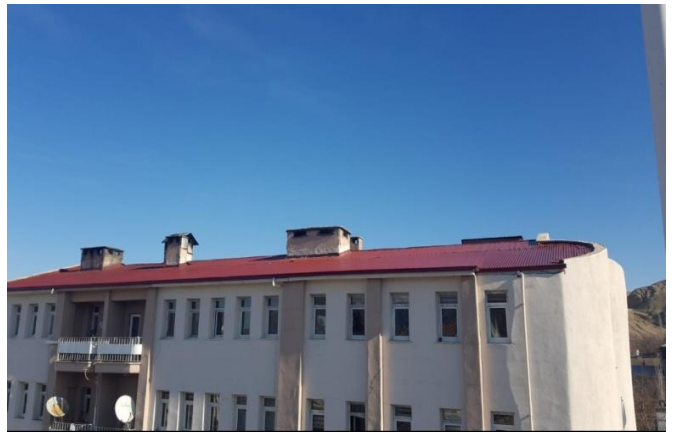
Tuzluca İlçe Emniyet Müdürlüğü Çatı Bakım Onarım İşi
