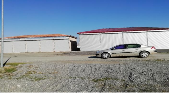
Toma Garajı Yapım İşi
