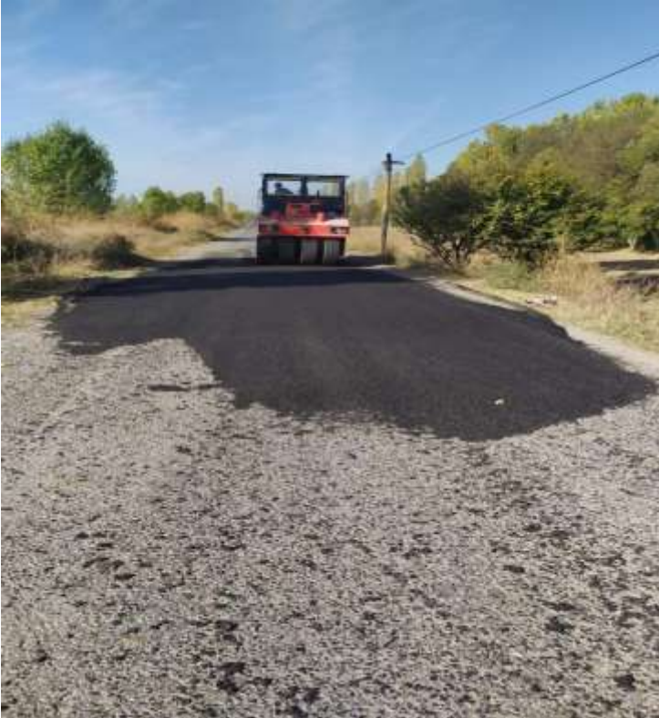
Yk. Alican Köy Yolu Asfalt Bakım Onarım Çalışması
