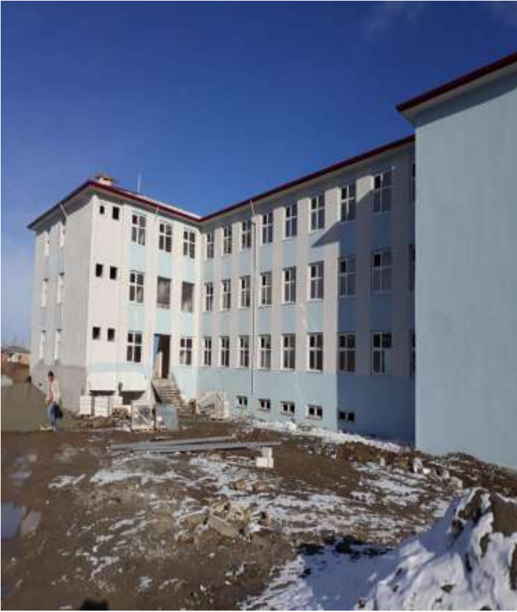
Tuzluca EML Atölye Yapım işi
