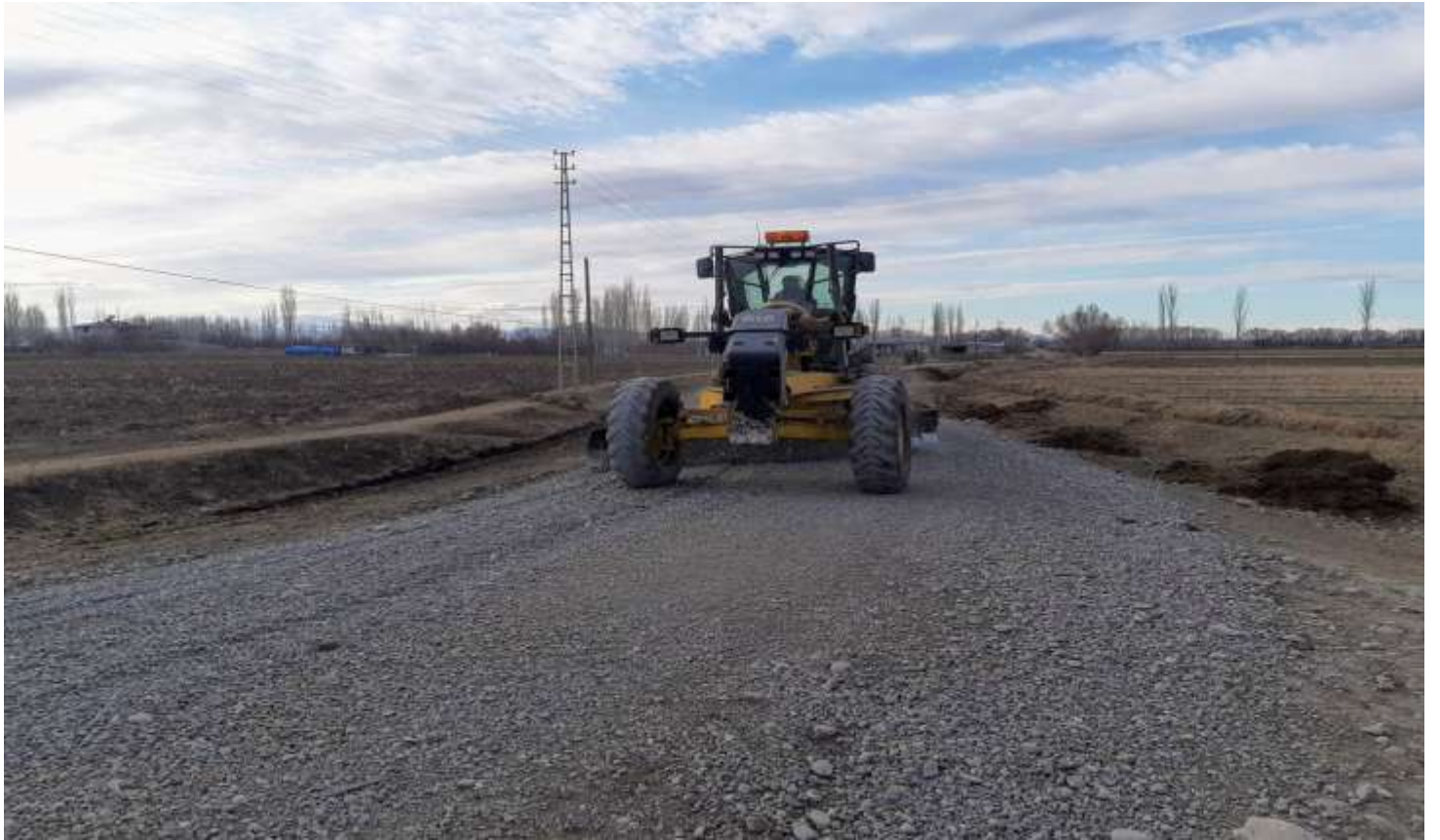
Enginalan Köyü Tarla İçi Yollar Greyderli Bakım Çalışması
