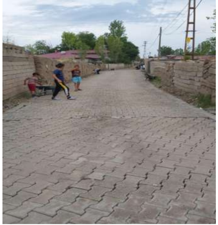
Panik Köy Yolu Parke Yapımı
