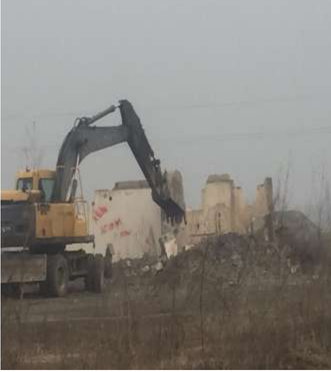
Metruk Bina Yıkımı
