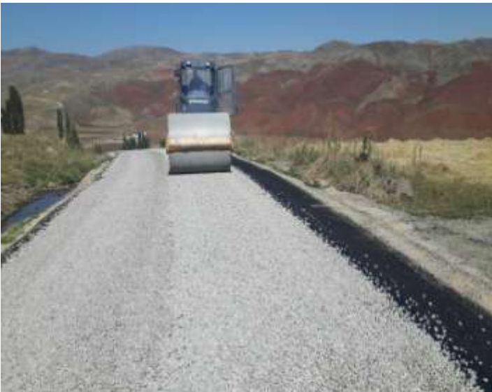
Sarıbulak Grup Yolu Sathi Kaplama Çalışması
