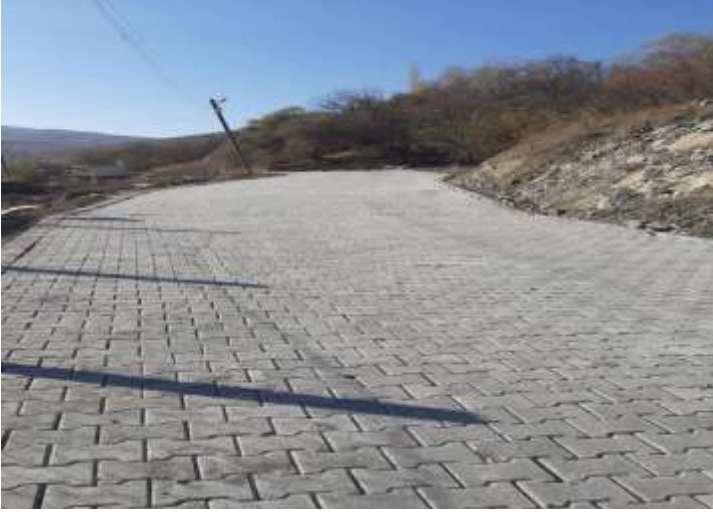
Uğurca Köy Yolu Parke Yol Yapım Çalışması
