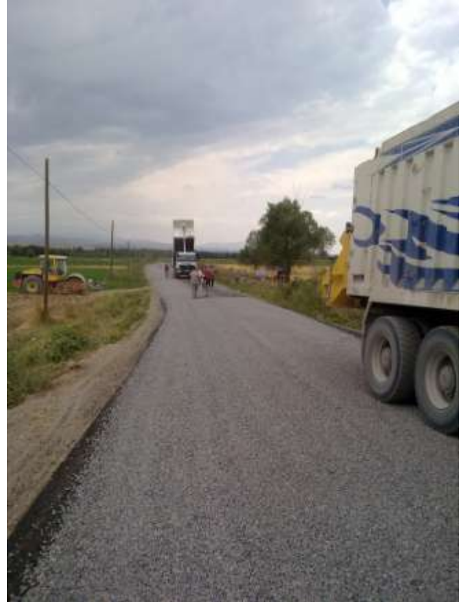
Adetli Köy Yolu Sathi Kaplama Çalışması
