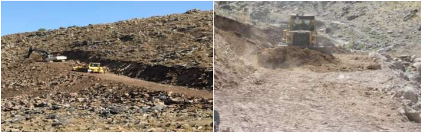
Korhan Meşelik Ve Boyluca Yolu Yol Onarımı Çalışması
