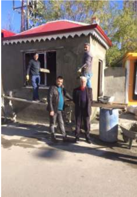
Aşevi Yapımından Görünüm
