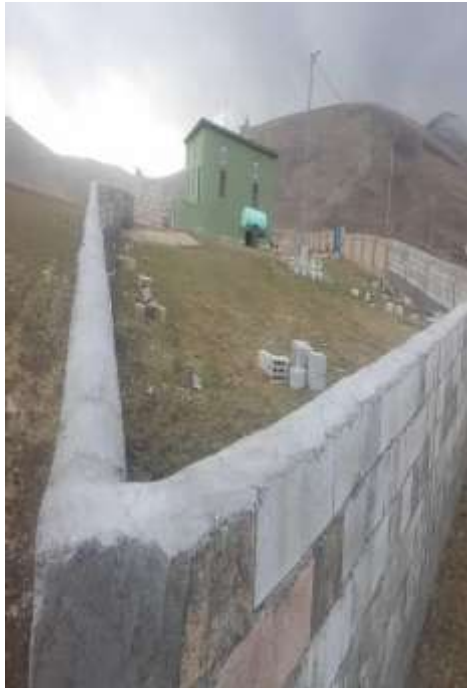
Cami İhata Duvarı Yapımı
