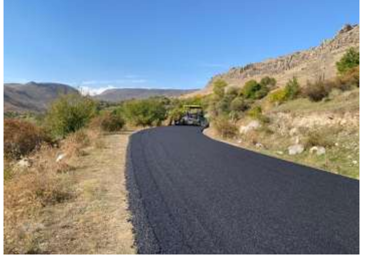
Aş. Sutaşları Köy Yolu Bsk Asfalt Kaplama Çalışması
