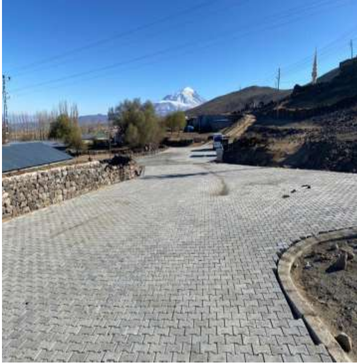
Aliköçek Köy Yolu Parke Yapımı
