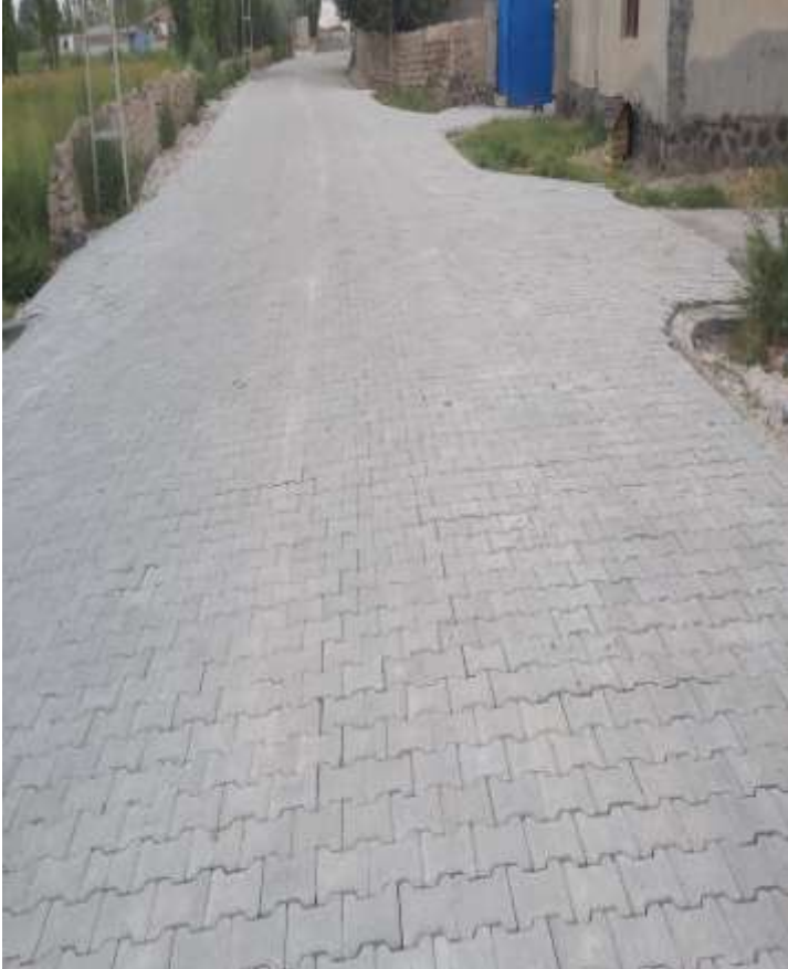
Hasanhan Köy Yolu Parke Yol Yapımı Çalışması
