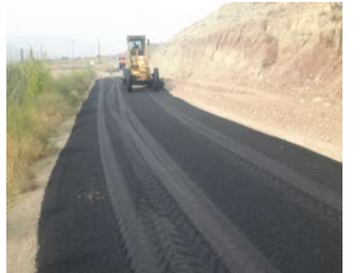
Gaziler Grup Yolu Soğuk Uygulamalı Asfalt Yama Malzemesi İle Asfalt Bakım Onarımı
