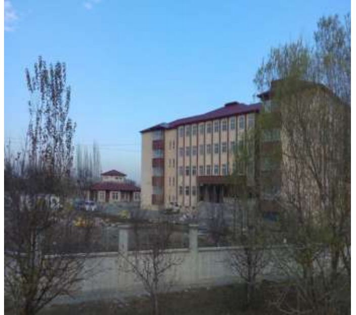
Hakveyis Mahallesine 24 Derslikli Temel Eğitim Okulu ve 4 Derslikli Anaokulu Yapımı
