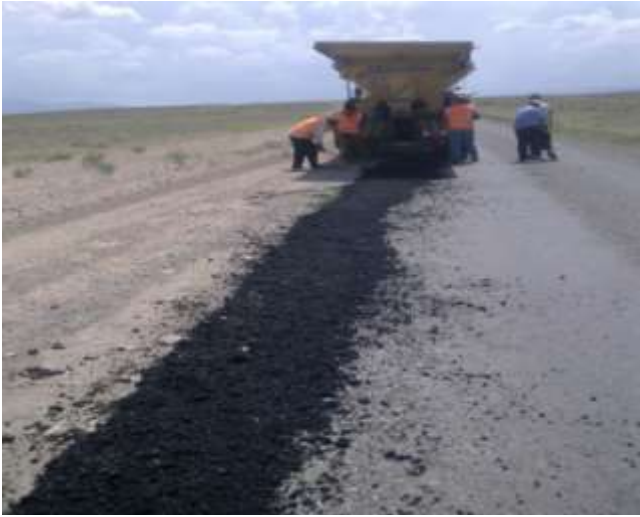
Asfalt Yama Çalışmalarından Görüntüler
