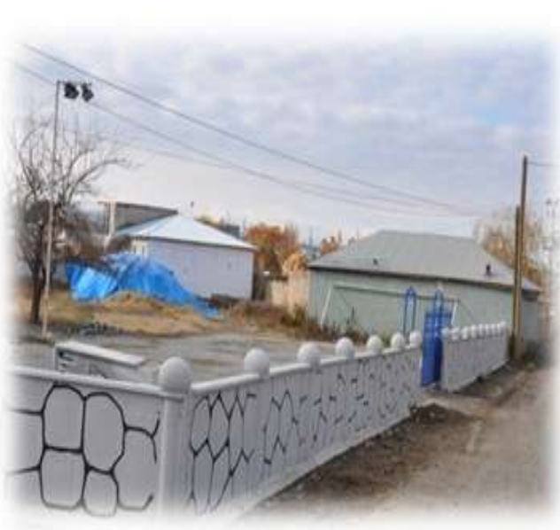
Mezarlık İhata Duvarı Yapımı
