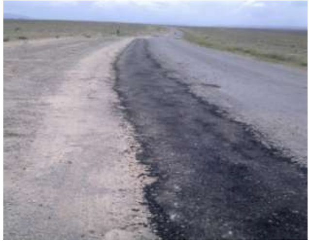
Asfalt Yama Çalışmalarından Görüntüler
